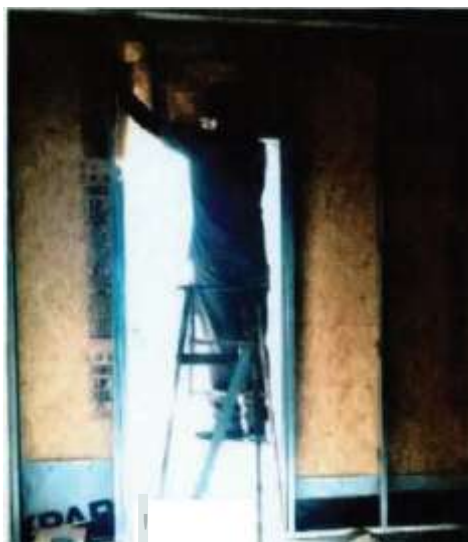
Figura A.3- Colocación de lana de fibra de vidrio en la parte interna del sistema
