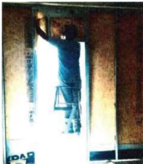
Figura A.3 - Colocación da lana de fibra de vidro en la parte Interna del sistema.
