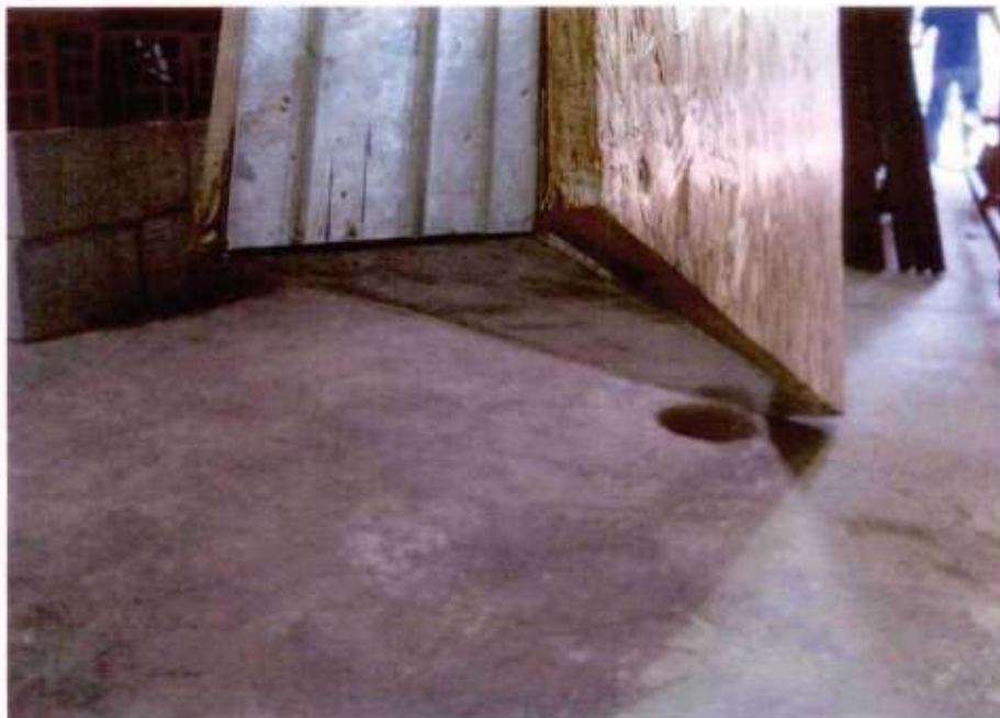
Foto 4 Pared P1-vista de las placas de cerradura del OBS y del yeso acartonado montadas a la pared sin cubrir totalmente el perfil metálico inferior-
