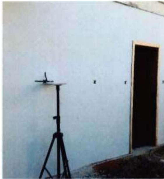
Figura A.5 - Parte externa del sistema con revestimiento de Placa Cementicia terminada.
