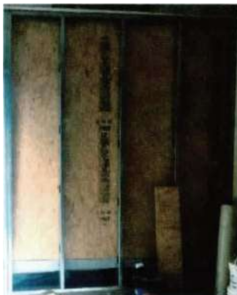
Figura A.2- Fijación de placas LP OSB
