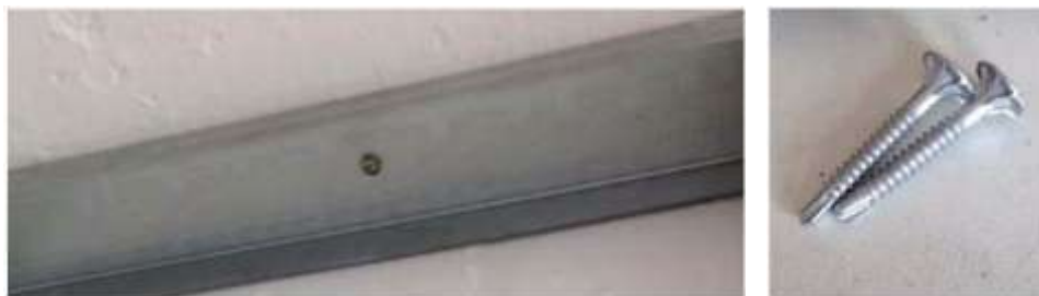
FiguraA.1-Fijación del perfil guía.
