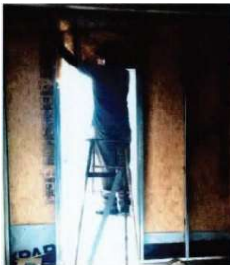
Figura A.3 — Colocación de lana de fibras de vidrio en la parte interna del sistema
