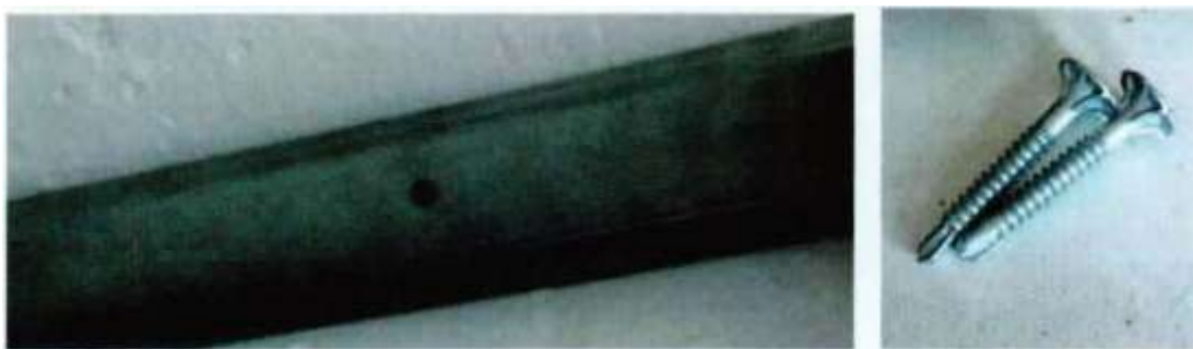
Figura A.1 – Fijación del perfil guía
