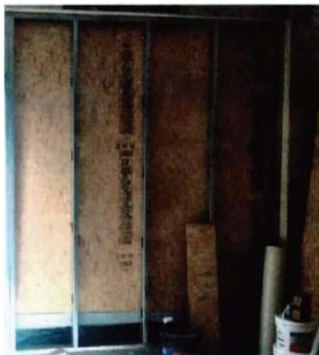
Figura A.2 — Fijación de la placa LPOSB
