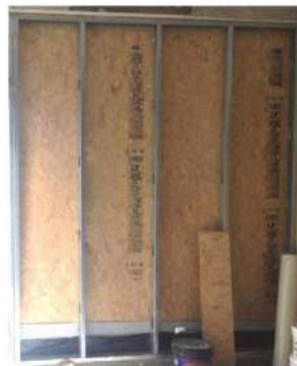
Figura A.2-Fijación de las placas LP OSB
