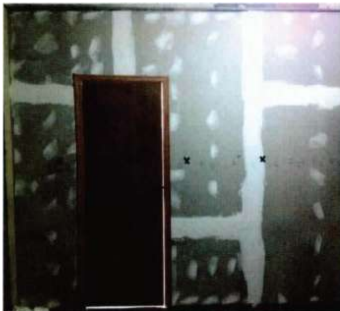
Figura A.4 -Cuerpo de yeso después del tratamiento de juntas de placas de yeso
